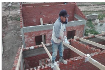
Aanbrengen houten constructie
