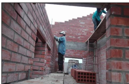
Vorbereiding dragende muren
