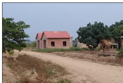
Woningen onder dak
