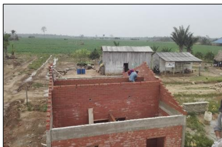
Laatste metselwerken woningen voor de leerkrachten
