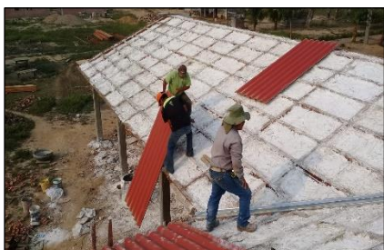
Onderdak wordt aangebracht
